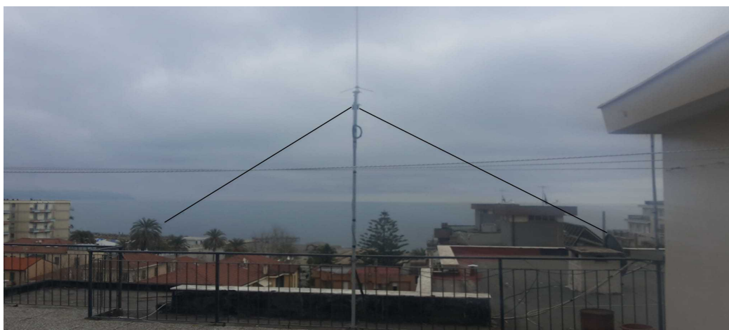
Antenna (i fili sono evidenziati in nero perchè invisibili nella foto)
